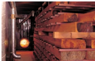
乾燥室内部を130℃まで上げ、乾燥と脱脂まで行います。
