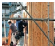
7 耐震パネル (壁倍率3.3倍)
