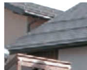
25 屋根材屋根工事・ 耐摩カラーGL 軒の出は妻側750mm 桁側600mm
