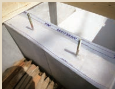
土台ガードでコンクリートの水分遮断
